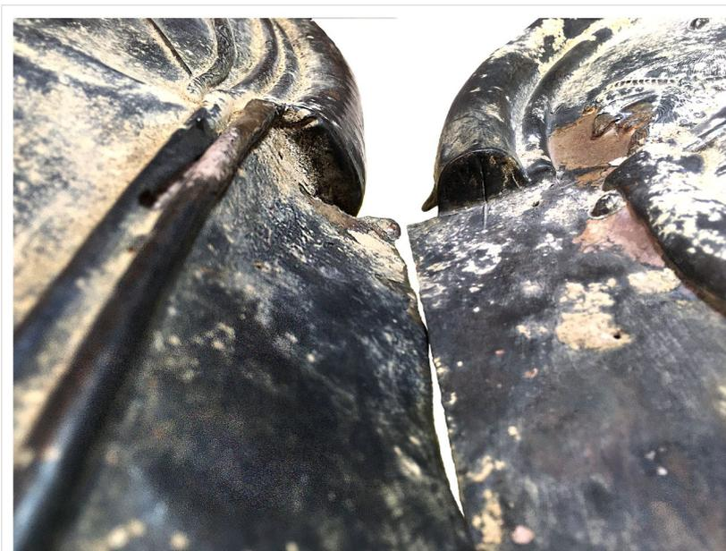
**Fig. 4B.** Interruzione della ringhiera (sporgente) in corrispondenza del montante (piatto).
